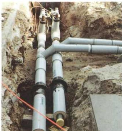
Высокий коэффициент теплоизоляции жесткого пенополиуретана из **Elastopor H**, прочно соединяющего в одно целое трубу-оболочку и трубу с рабочей средой, позволяет поддерживать необходимые, минимальные перепады температур на больших расстояниях.
