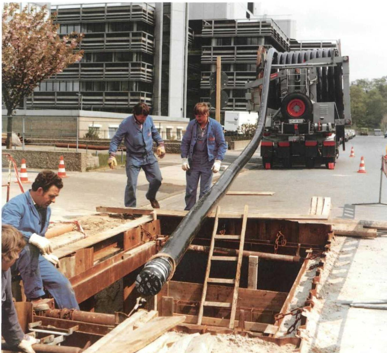
Как дополнение к жестким системам трубопроводов используются гибкие многослойные трубопроводы, отвечающие специальным требованиям.
