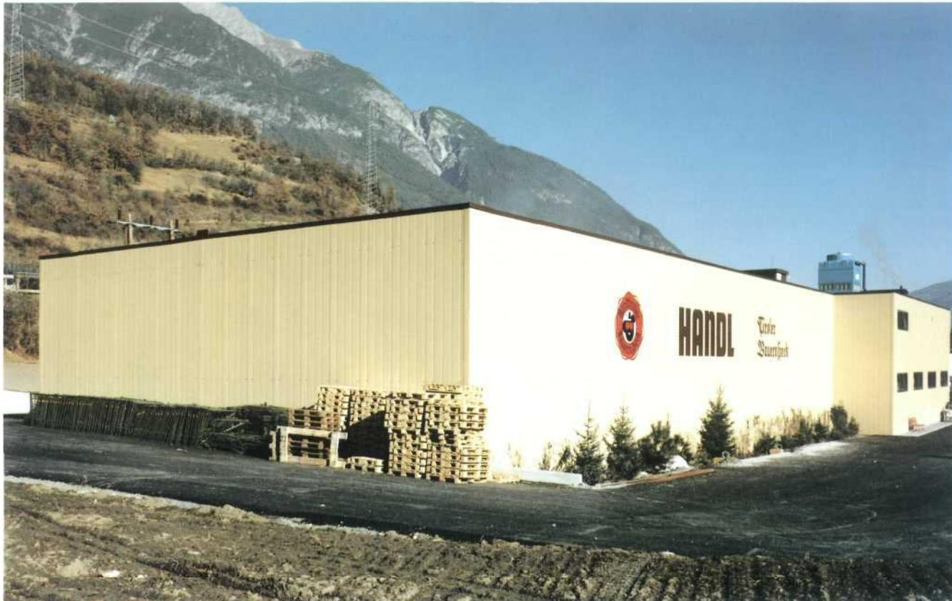
Теплоизоляционные панели для скоростного строительства с сердцевиной из жесткого пенополиуретана **Elastopor H** представляют собой готовые сборные панели типа „сэндвич“. Они обеспечивают рациональный монтаж и самую высокую степень надежности с точки зрения строительной физики и применяются специально для производства промышленных холодильников, холодильных камер, а также для сооружения зданий павильонного типа.
