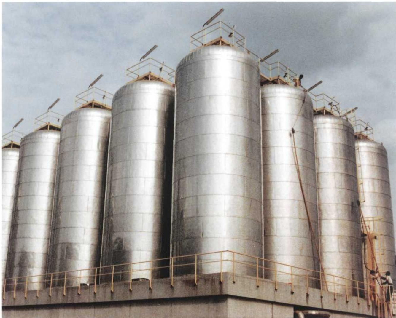
Литевая пенополиуретановая система **Elastopor H**, применяемая по методу изоляции с наружной оболочкой, позволяет прямое использование на изолируемом объекте.
